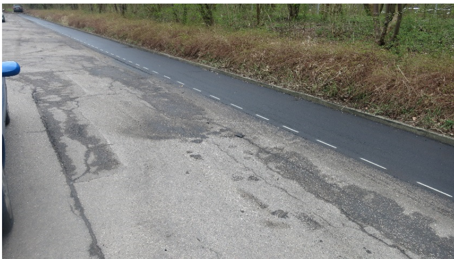
Figur 6 – Udført arbejde: nyt og gammelt asfalt udlagt i striber på 1.25 meters bredde.
