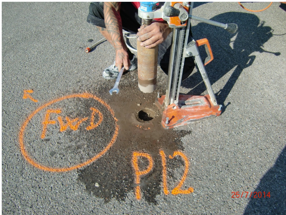
Figur 4 – Optagning af borekerne ved P12, samt markering af hvor faldlodsmålingen skal foregå (FWD)
