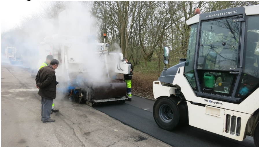
Figur 5 - Fræsning, opblanding, udlægning og efterfølgende tromling
