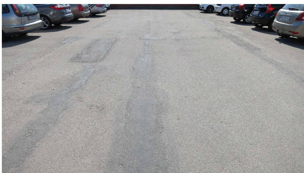
Figur 3 – Udbredte belægningsskader på P26
