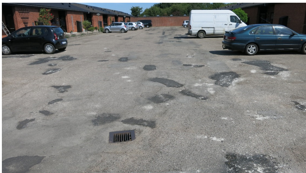
Figur 2 – Udbredte skader på det meste af P12.
